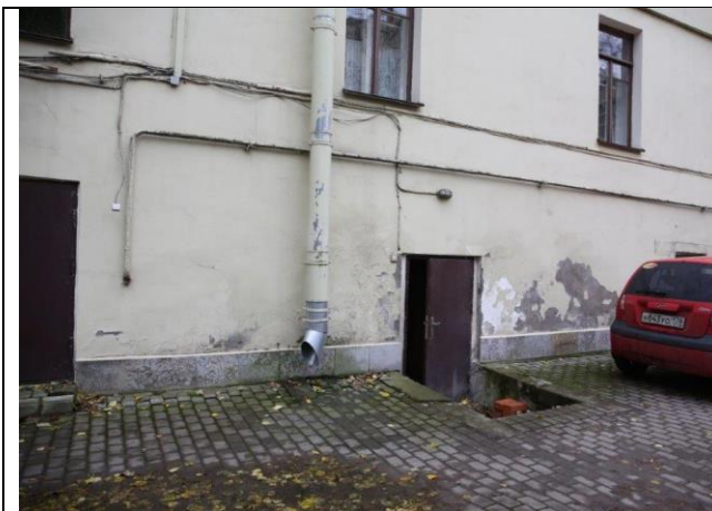
Фото № 7 – Вход в помещение со двора
